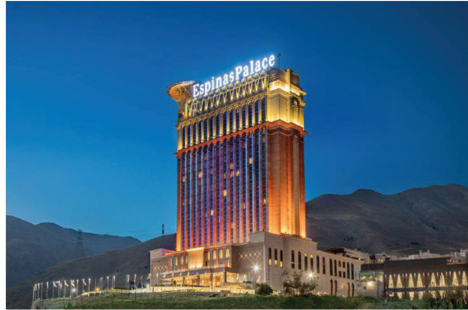
اجرای عایق صوت طبقه شاه نشین هتل اسپیناس پالاس
