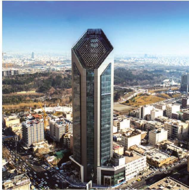
اجرای عایق حرارتی و دودبند کل تراز طبقات برج جهان کودک
